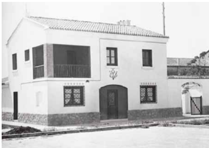
2. Casa del médico En Jose Hinojosa en la Calle La Tauleta. Actualmente está el edificio de Servicios Sociales del Ayuntamiento.
