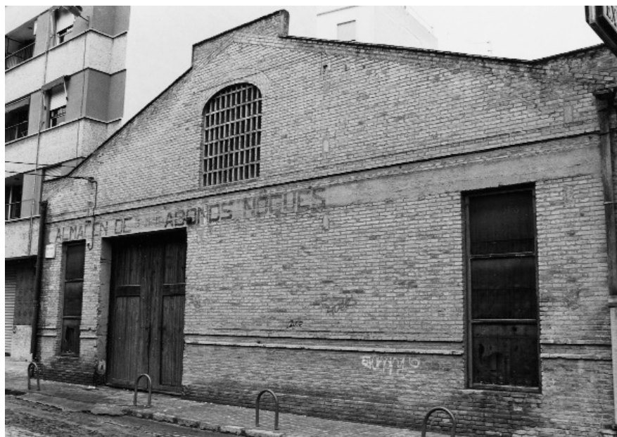
9. Almacén de abonos "Noguera" en la Calle del Furs
